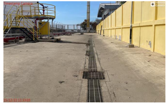
ภาพที่ 2 รางระบายน้ำคอนกรีตภายในคลัง
