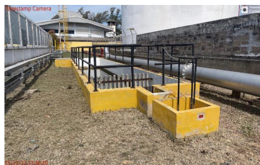
ภาพที่ 9 บ่อดักคราบน้ำมัน Oil interceptor เพื่อทำการแยกน้ำมันออกจากน้ำก่อนระบายสู่สาธารณะ
